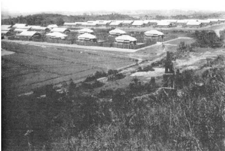
圖9 烏山頭職員宿舍舊照片
