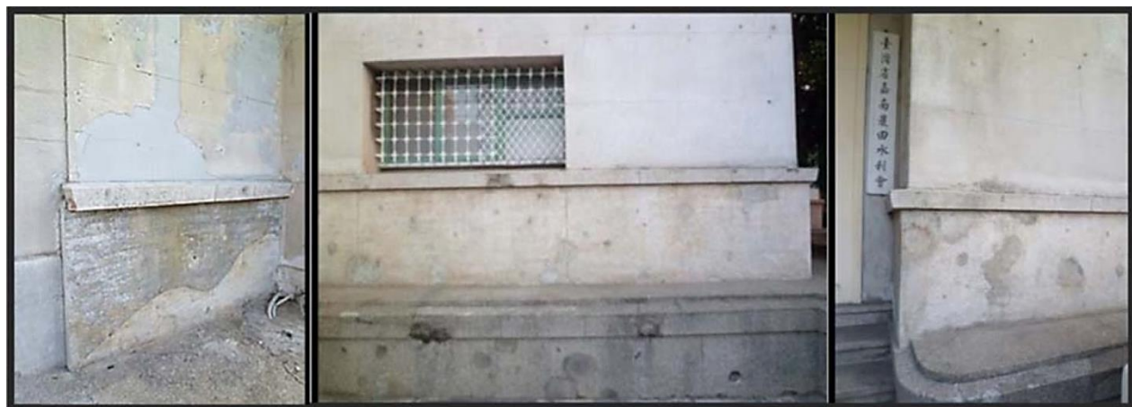
圖 2.磁磚剝落現出斬石子牆面留有 1941 年塗色的「防空迷彩」妝
