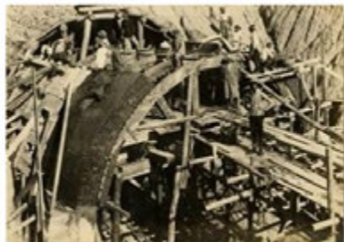
烏山頭排水隧道取入口
