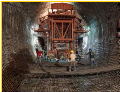
防淤隧道襯砌鋼筋綁紮
