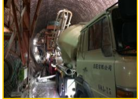
防淤隧道砌混凝土澆置
