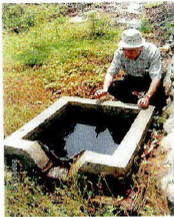
1.0.0.85 溢流出口 三角ノツツ高 2.5cm 水量 8.372/分 (2007年5月8日)
