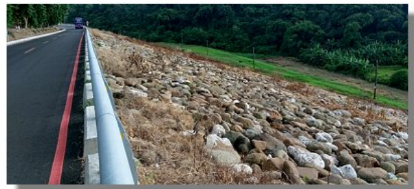
大壩下游坡面現況
