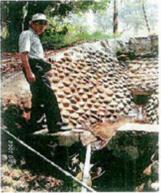
3.8.0K貯集出口 三角ノッチ高 7.0cm 水量 108.011/分 (2007年5月8日)
