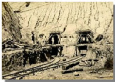
烏山頭排水隧道取入口
