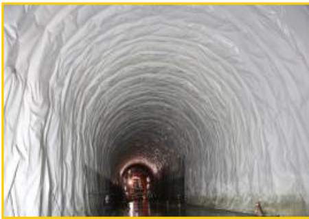
防淤隧道防水膜鋪設
