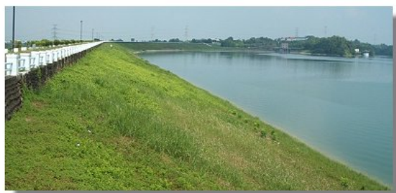
大壩上游坡面現況
