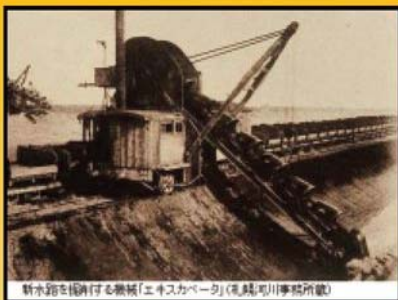
新水路掘削機械(挖土機) (目前仍有機具保存於札幌河川 事務所)
