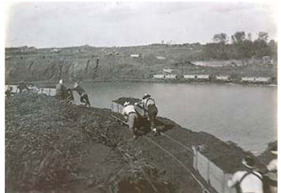
▲泥炭地では、人がトロッコをひいて土砂を運搬して（札幌河川事務所蔵） 在泥炭地上人拉台車搬運砂石
