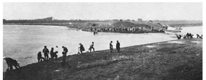
▲昭和11年、夕張川新水路の通水（「石狩川治水史」から） 昭和11年、夕張川新水路通水（取材自「石狩川治水史」）
