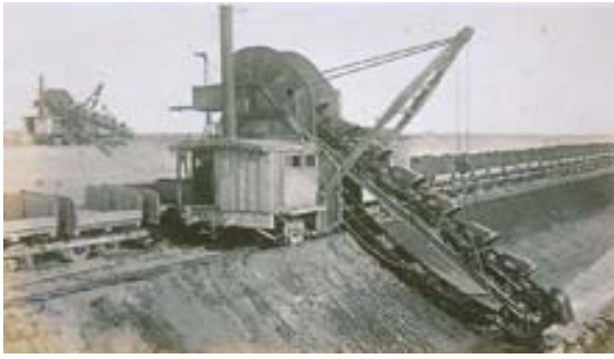
▲エキスカベーターによる掘削（木製の五合積土運車で運搬） 以挖土機挖掘（以木製五合積土運車搬運）
