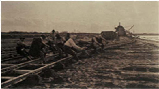
▲昭和3年頃の掘削機土取場線路移動作業（札幌河川事務所蔵） 昭和3年左右挖土機挖土場軌道移動作業
