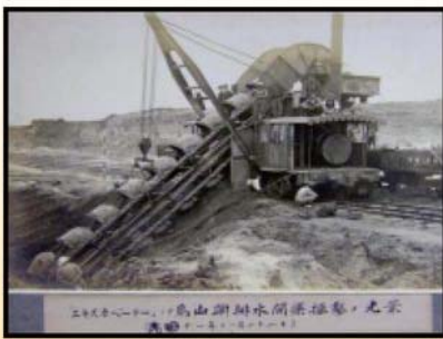
烏山頭鑿掘作業用的挖掘機 (エキスカベータ) (1922)。
