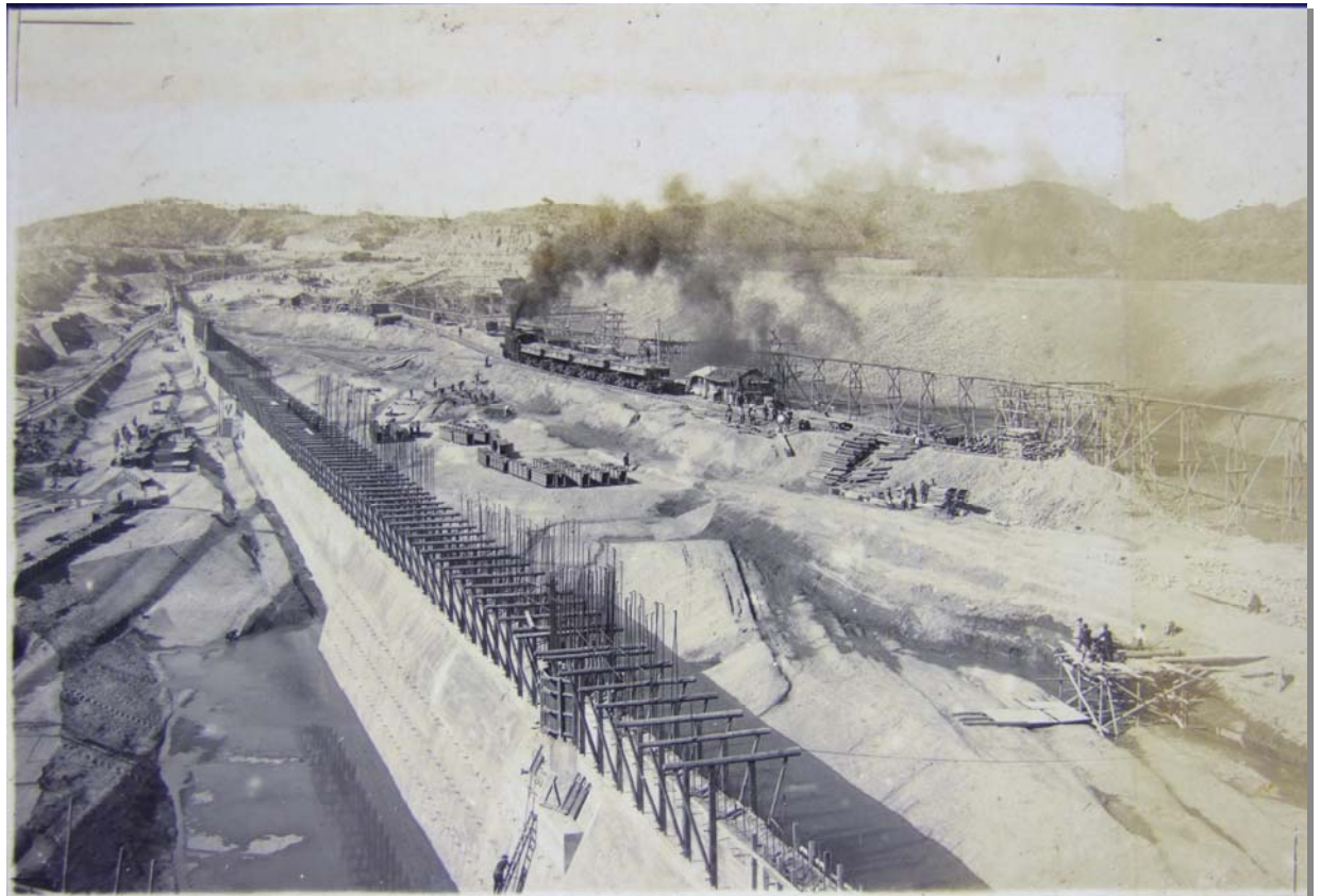
堰堤中心混凝土作業
