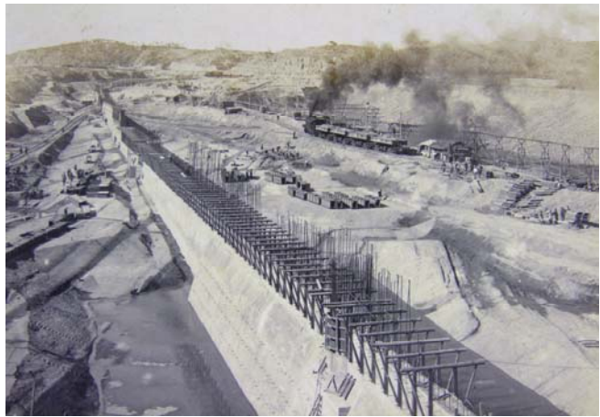
嘉南大圳の中心であるダムの基礎工事の様子
