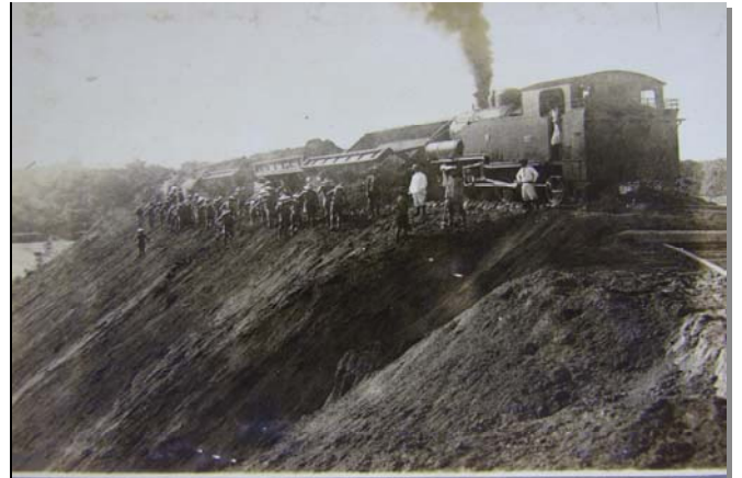
烏山頭開渠掘鑿土砂捨場光景 (民國十一年十月二十五日)
